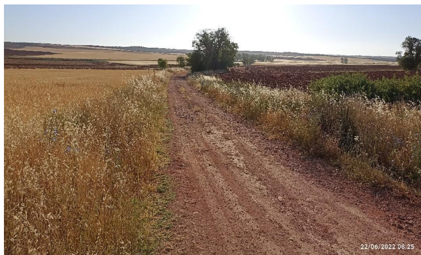
Estado de algunos tramos intermedios
