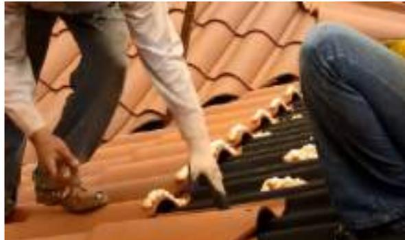
Esta forma de coger las tejas se escoge por ser mas ligera que cogerlas con mortero de cemento, con lo cual se le facilita el trabajo al operario.
